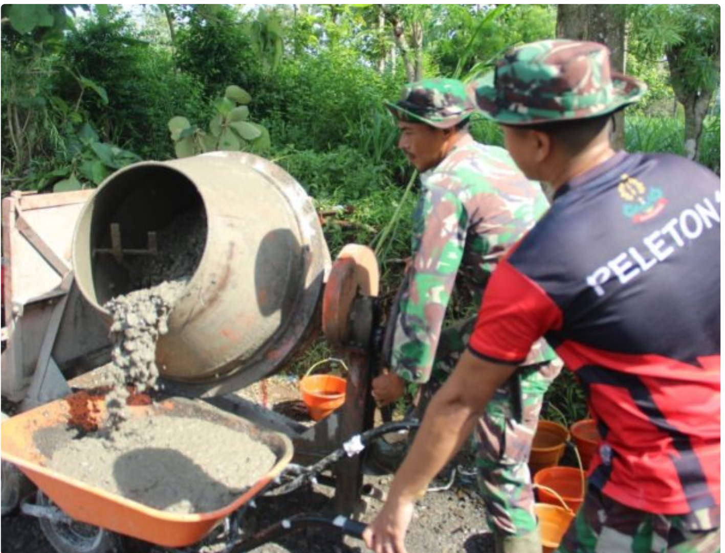
Foto : Betonisasi Jalan Program TMMD Reguler 119 di Desa Tanjungrejo, Kecamatan Margoyoso, Kabupaten Pati, Jawa Tengah, Minggu (25/2/2024).
